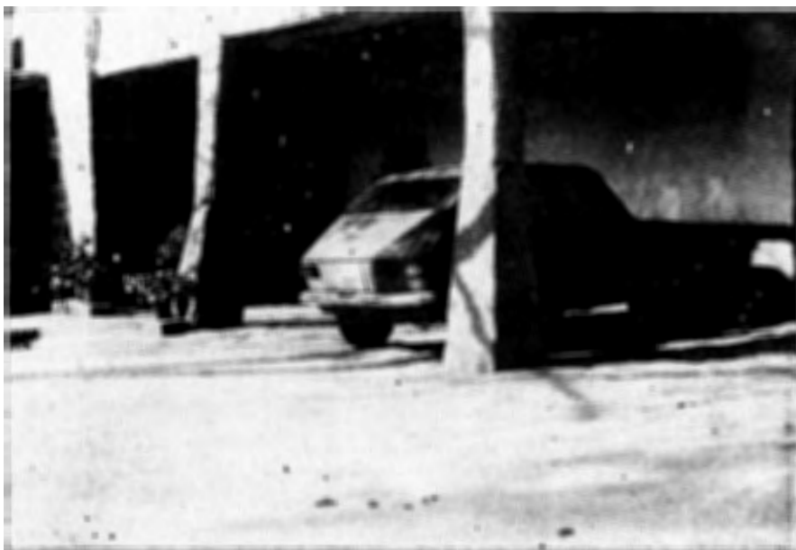
Foto 7: Dos postes tronco-piramidales de arenisca, sosteniendo el primer piso del caserío de Uriarte, en el barrio de Cengotita, de Mañabla.
